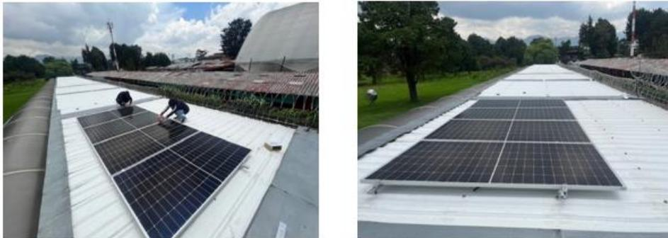
Figura 12. Instalación de los paneles solares.
