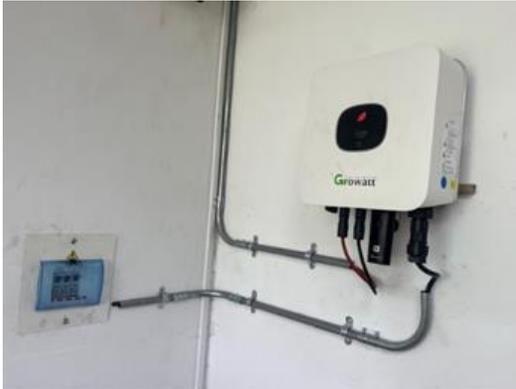
Figura 9. Dispositivo Growatt instalado.
